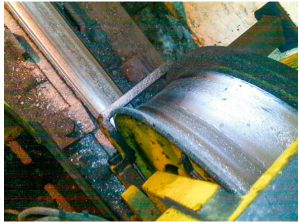
Degradacja lewego obrzeża koła jazdy suwnicy
