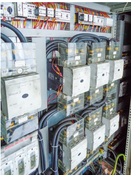
Topografia stycznikowo – przekaźnikowa wnętrza klasycznych szaf sterowniczych
